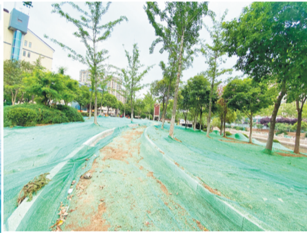
施工现场内一角。
