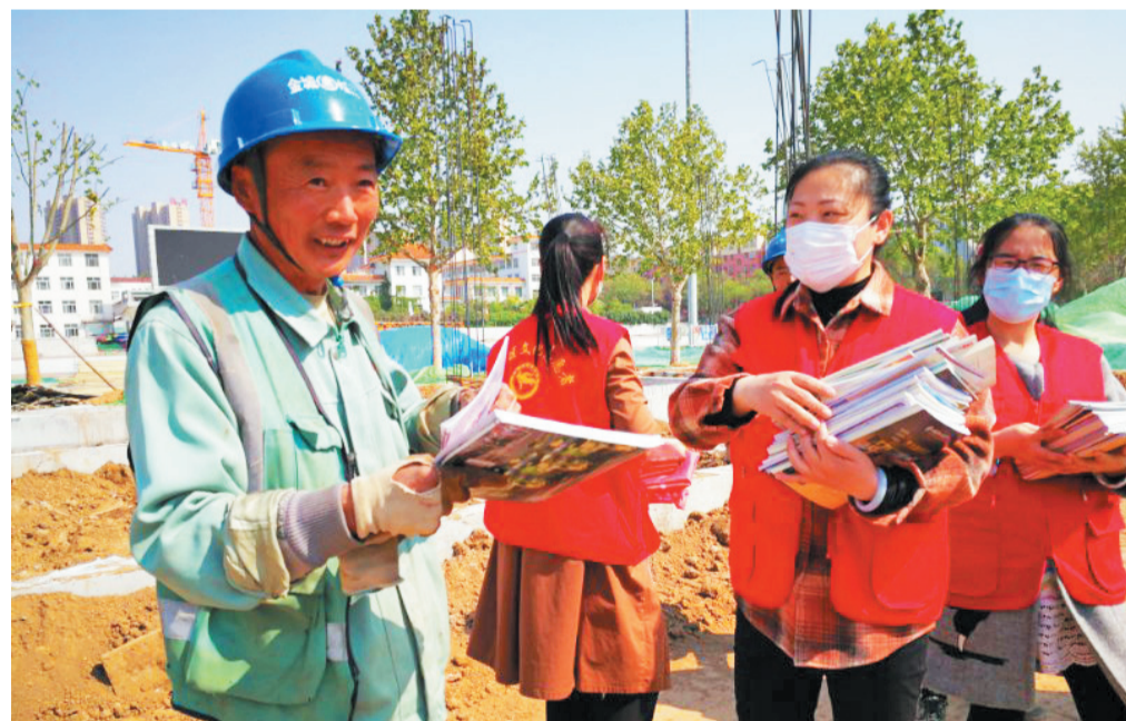
淄川区图书馆工作人员走进鲁泰体育场升级改造项目工地为农民工送图书。
