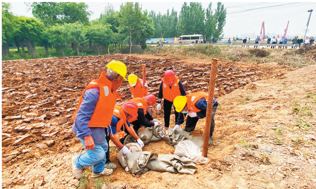
5月16日,淄博市2020年水旱灾害防御演练现场,抢险队员正在垒沙袋。
