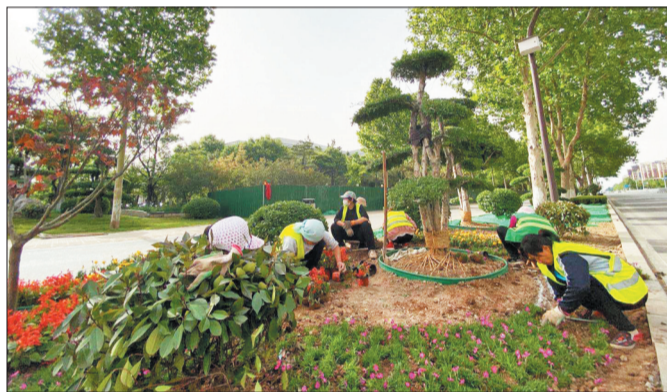
施工人员正在打造分隔带内的新景观。
