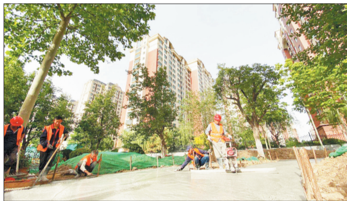
游园步道正在施工。
