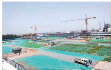
海益橡胶项目建设现场。
