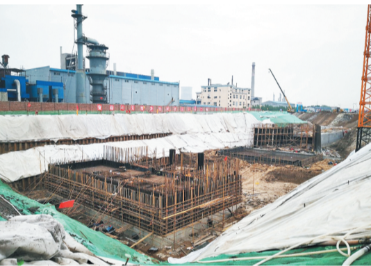
5月15日,杏花河泵站正在建设中,该泵站基坑开挖深度最深处超过11米。
