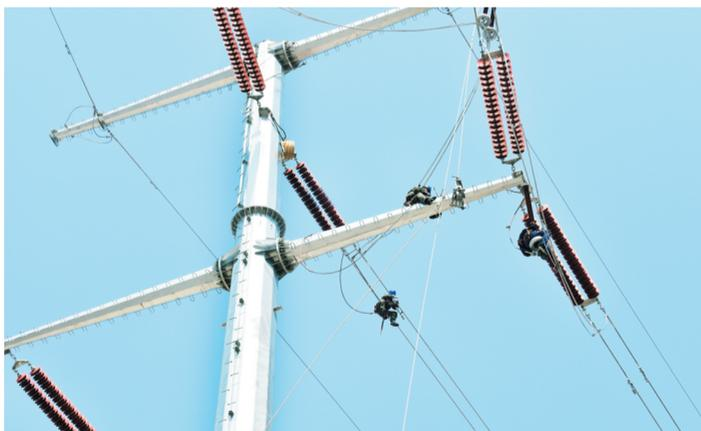
5月21日,施工队为新建线路220kV盛里线4#铁塔安装跳线。
