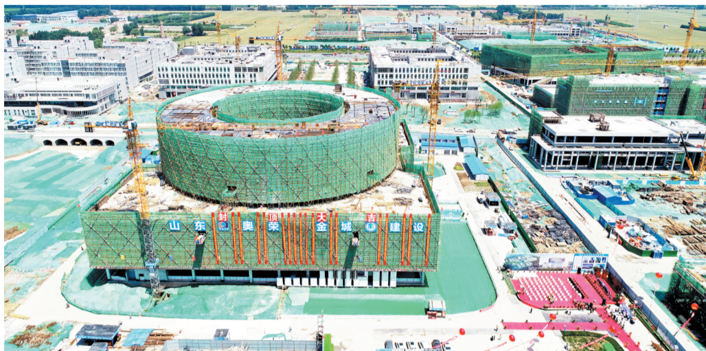
完成封顶的图书馆航拍。
