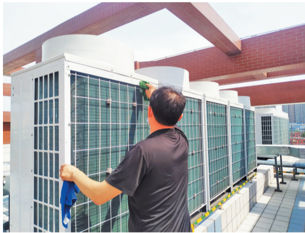
工作人员对中央空调进行消毒。
