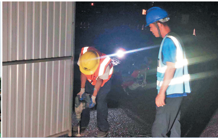
中润大道改造工程施工转入南半幅,图为6月7日晚,施工人员正在改设围挡。
