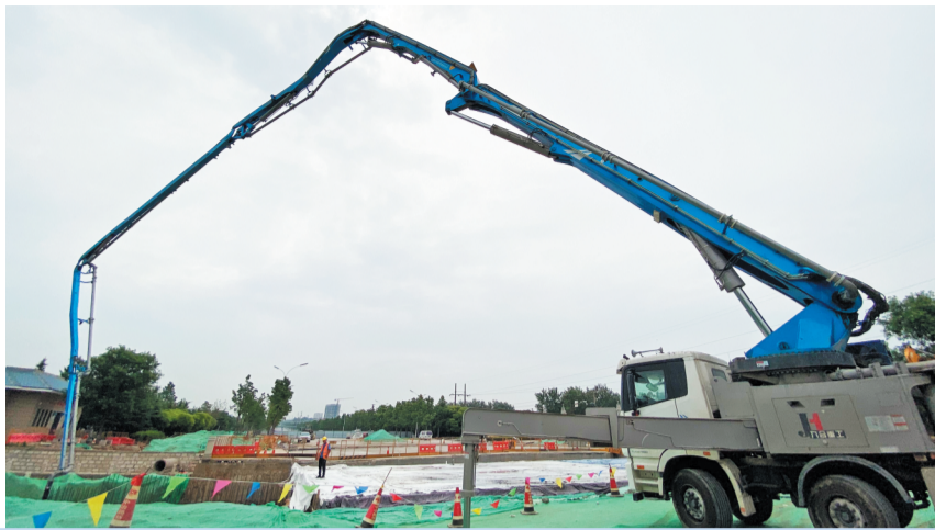
6月9日,涝淄河桥段新建桥体部分正在施工。
