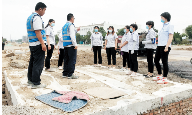
交流会后,所有人员到工程改造现场进行巡查。
