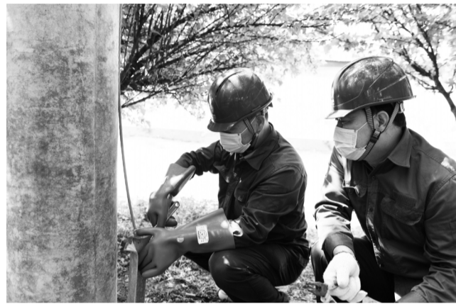
6月29日,临淄供电中心员工在10千伏齐都线4号杆为接地极加装双螺帽。
