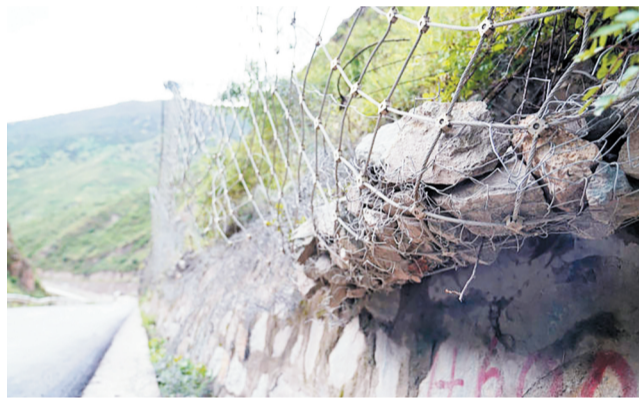
318国道芒康段,铁网兜住了山上掉落的石块。
