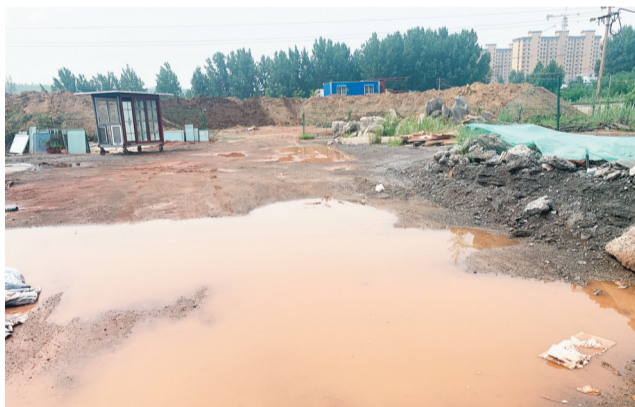
淄博经济开发区华福大道以南,北京奥瑞特国际照明工程有限公司院内,大面积渣土露天存放。
