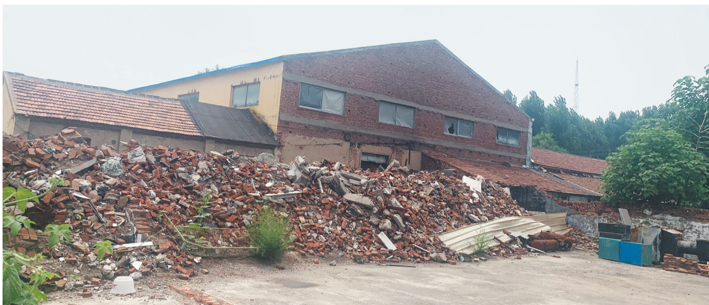
周村区青年路与西外环交叉口路北侧工业园一院内大量建筑垃圾露天堆积。
