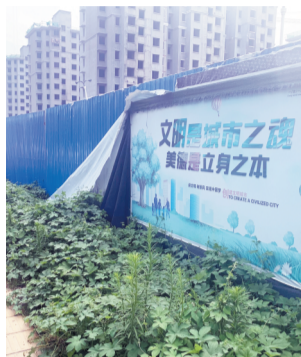
周村区北郊镇孙家寨棚户区改造项目周边公益广告残缺。
