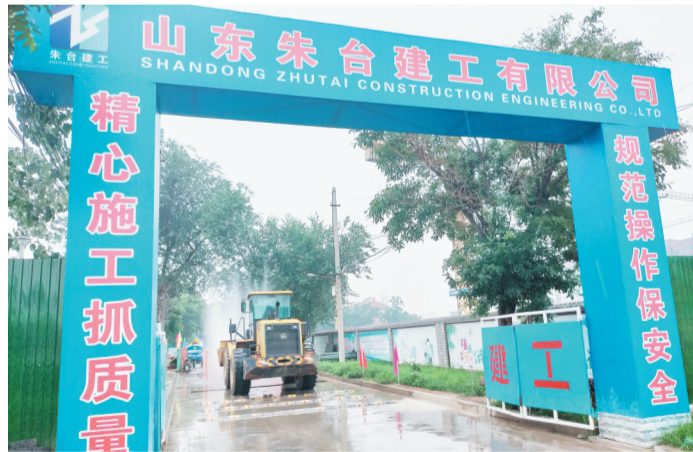
工地进出施工车辆正在冲洗。
