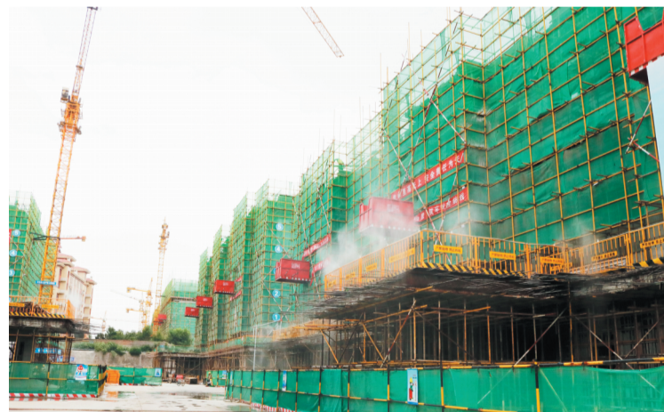
项目现场全部安装围挡。
