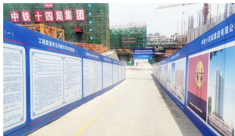
工地内道路全面硬化。
