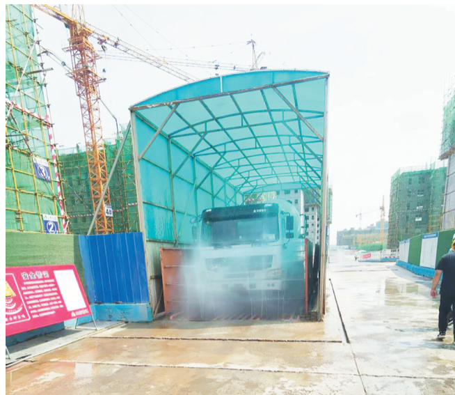
施工现场车辆进出必须经过冲洗。
