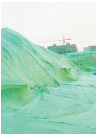
施工现场裸露面加盖防尘网。
