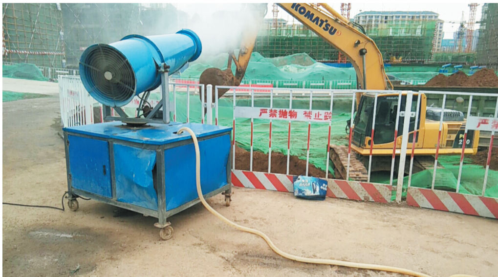
施工现场的雾化机。
