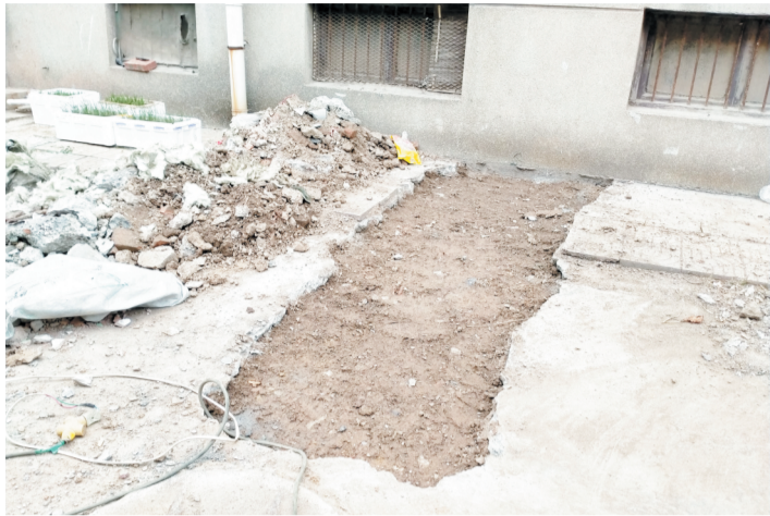
用于维修管道的沟槽已经重新填好了土。
