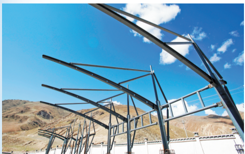
西藏昂仁县亚木乡小学运动场建设项目主席台和观众席的顶棚支柱正在进行加固。
