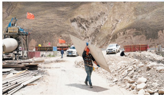
日吾其乡基础设施提升改造现场,工人们正在施工。
