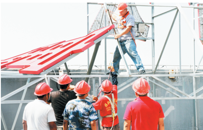
工作人员正在拆除楼顶广告。
