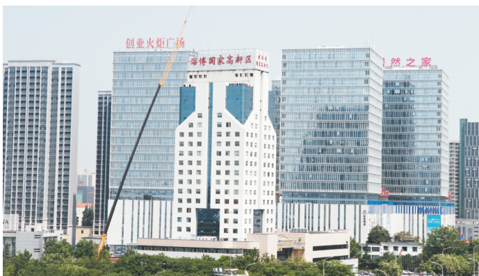
火炬大厦楼顶广告拆除中。
