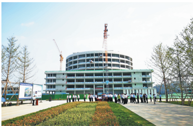
淄博大学城山东农业工程学院淄博校区项目。
