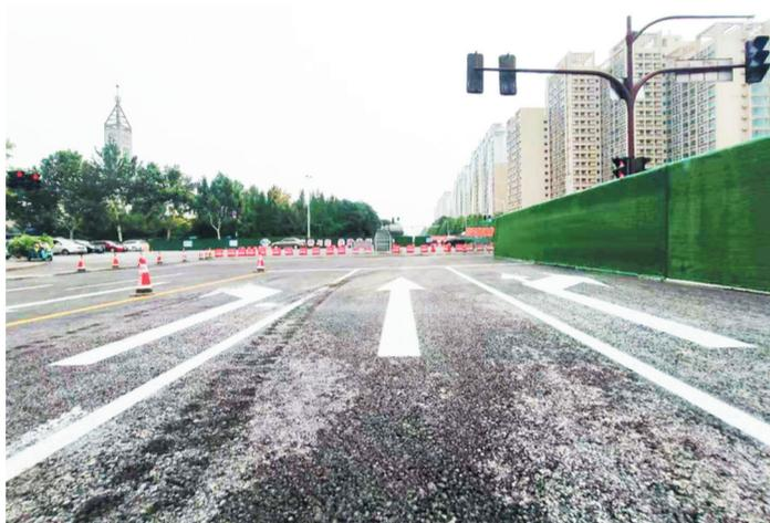
7月26日，联通路与世纪路交叉口以西路段的东半幅沥青下面层已铺设完毕，道路临时交通标线已施划好。
