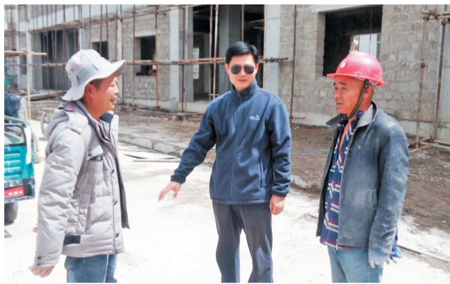
陈少勇(中)在项目施工现场。
