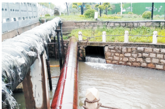
6日下午6点,金晶大道涝淄河桥西侧,雨水正由管网口排入河中,河道水位比一天前有所上涨。记者 孙渤海 摄
