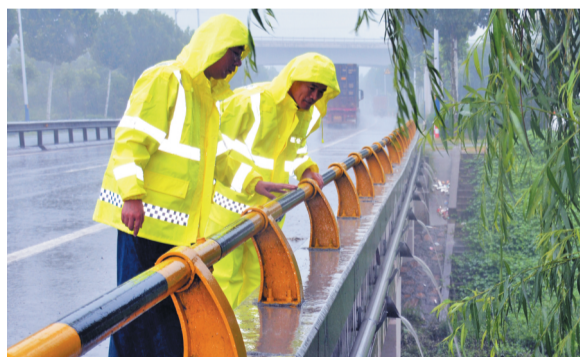
6日一大早,桓台公路事业服务中心路巡人员披上雨衣,奔赴辖区三条国道,进行公路巡查和安全排查,他们挨个检查桥面泄水孔,巡查过程中徒手清理被堵塞的泄水孔。记者 伊巍 通讯员 韩克辰 王峰 摄影报道
