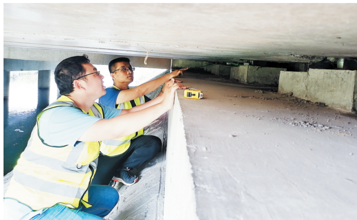
技术人员对桥梁进行安全隐患排查。
