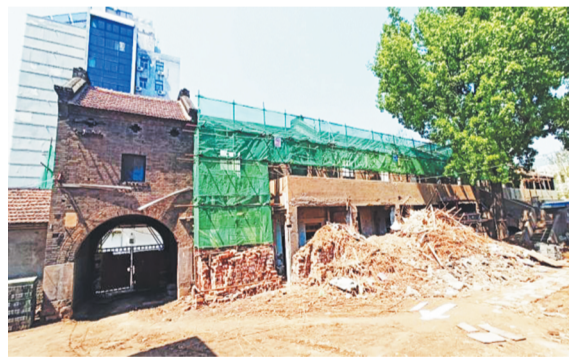
2020年4月13日,86号文物楼还在施工中。
