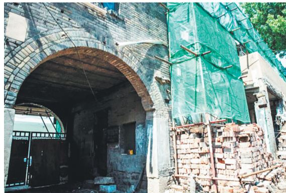
记者从门内拍摄的施工现场。
