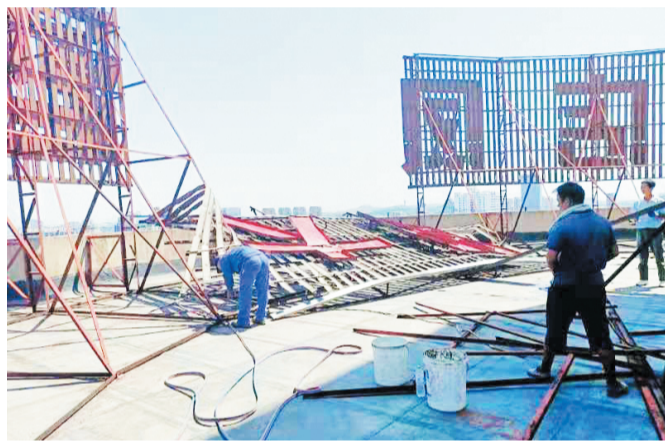
违规广告拆除现场。
