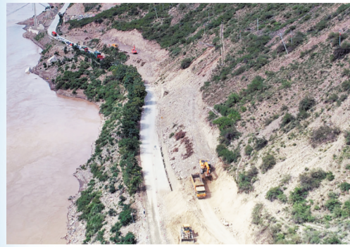
7月4日,318国道巴塘段,抢险施工机械正在清理塌方路段。
