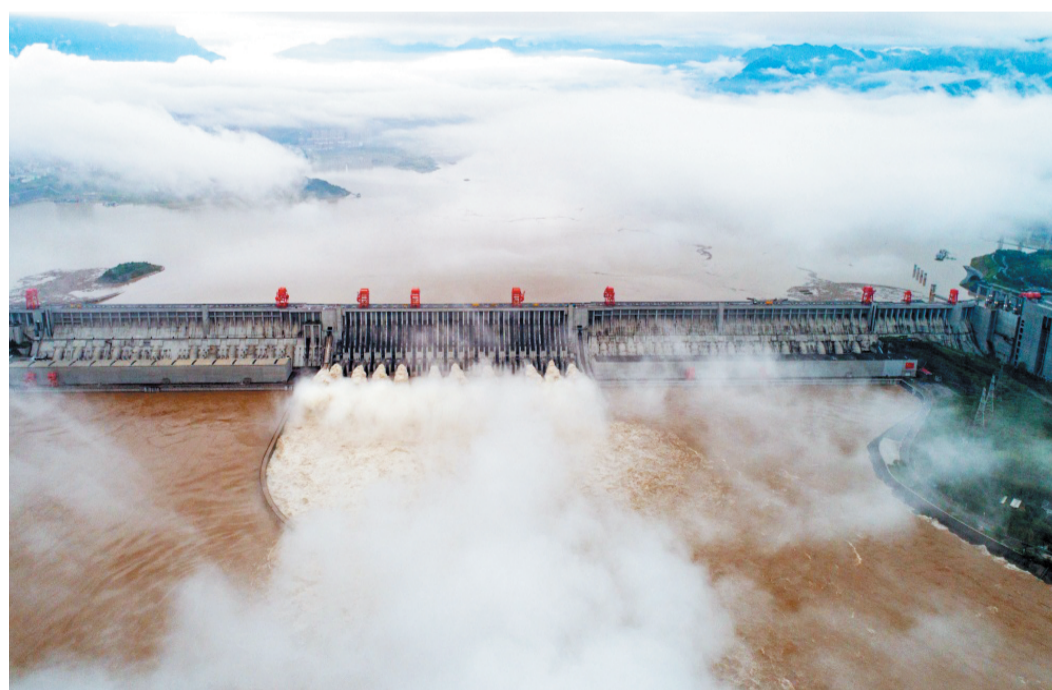
8月20日拍摄的长江三峡水利枢纽工程开启泄洪深孔泄洪的情景(无人机照片)。 新华社发
