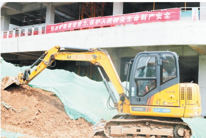
上地广场施工现场,带有“环3-FCE02231”字样的铲车正在作业。
