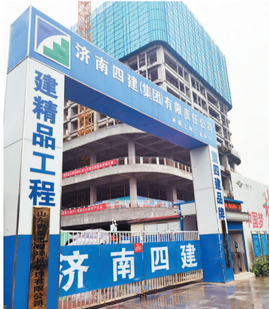
上地广场施工现场。
