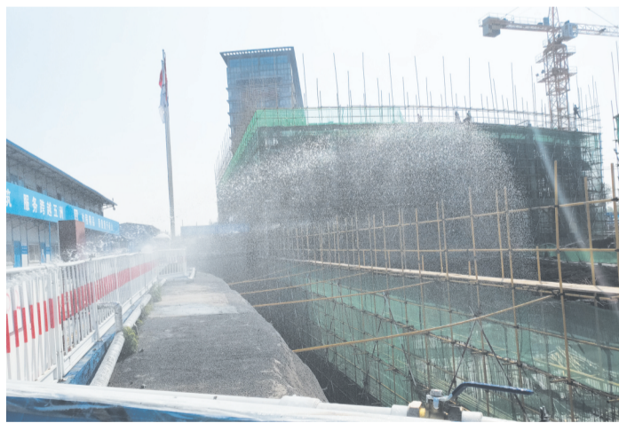
项目施工现场的智能喷淋系统。
