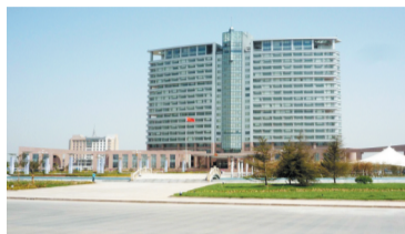
博兴行政中心综合楼(国优工程)
