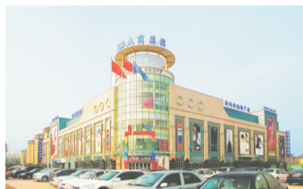
中润华侨城北区商业楼(国优工程)
