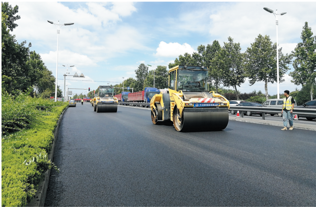
G308文石线中修工程周荆路口至新城路口段主体完工。
