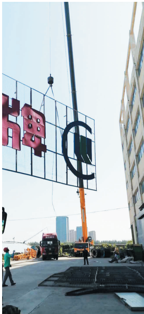
淄博高新区一处大型楼顶广告牌被拆下。
