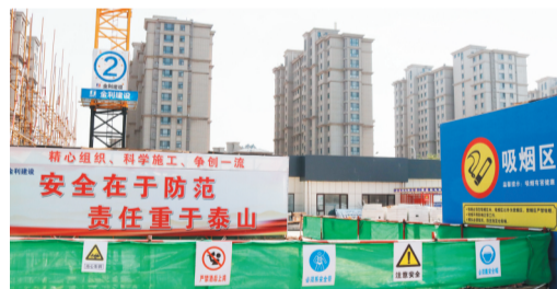
云星·齐都御园项目施工现场,竖立着各种醒目的安全标识牌。
