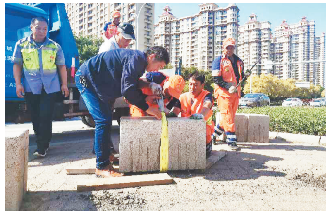
工作人员清理阻车石现场。
