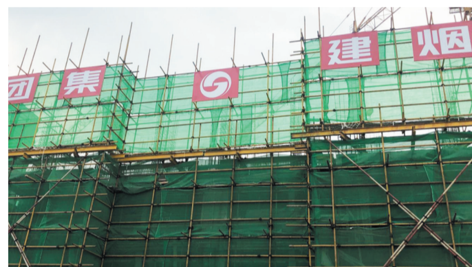
项目部建筑主体围挡施工。
