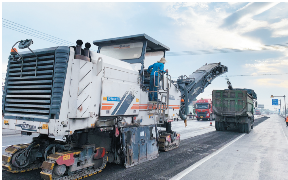
G308线前毕段进行路面微铣刨。
