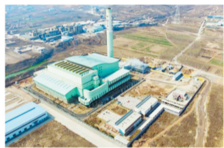
淄川绿能垃圾焚烧发电项目(国优)
