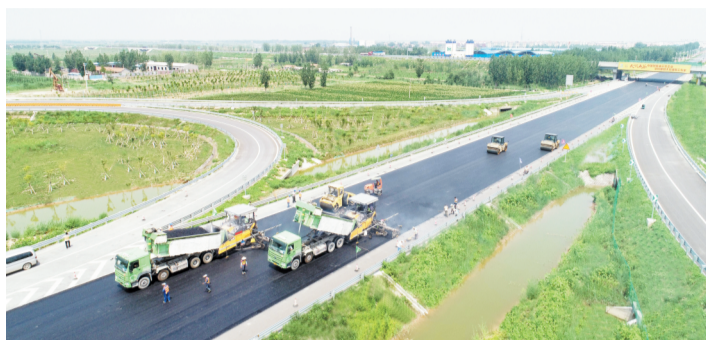
正在施工的城市干线。资料照片
