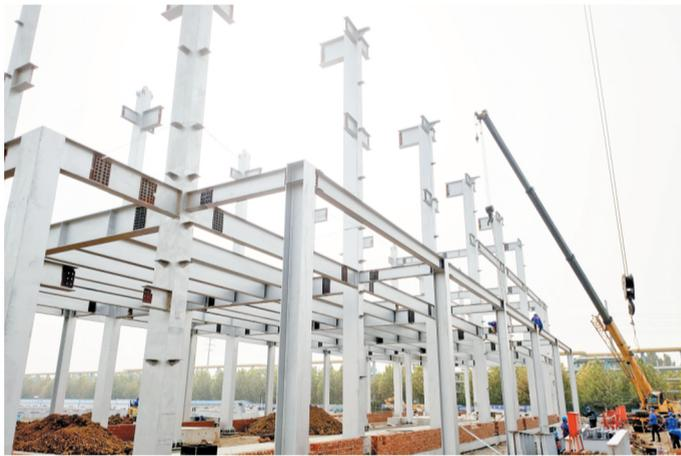
官保220千伏变电站配电楼钢结构横梁安装现场。
