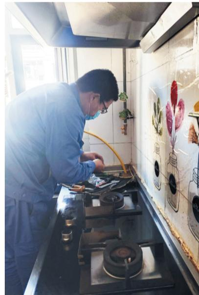
淄博华润燃气有限公司维修工上门为用户检查并更换“长寿命软管”。
