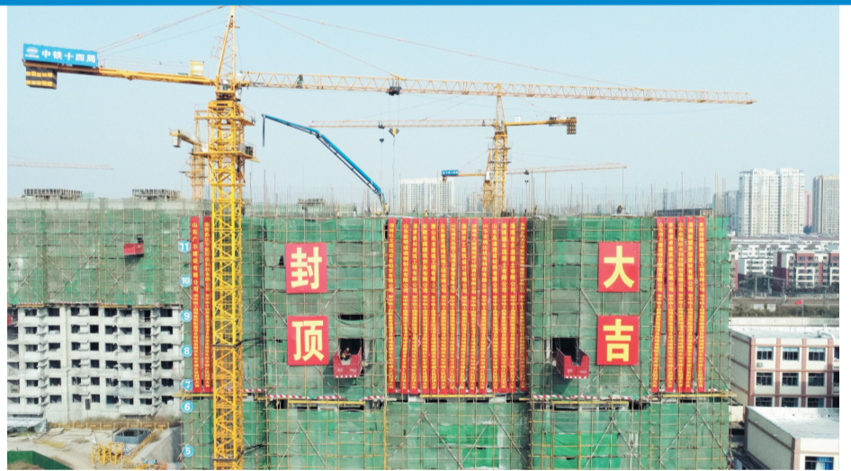
中铁十四局集团承建的辛店街道棚户区改造项目封顶。
