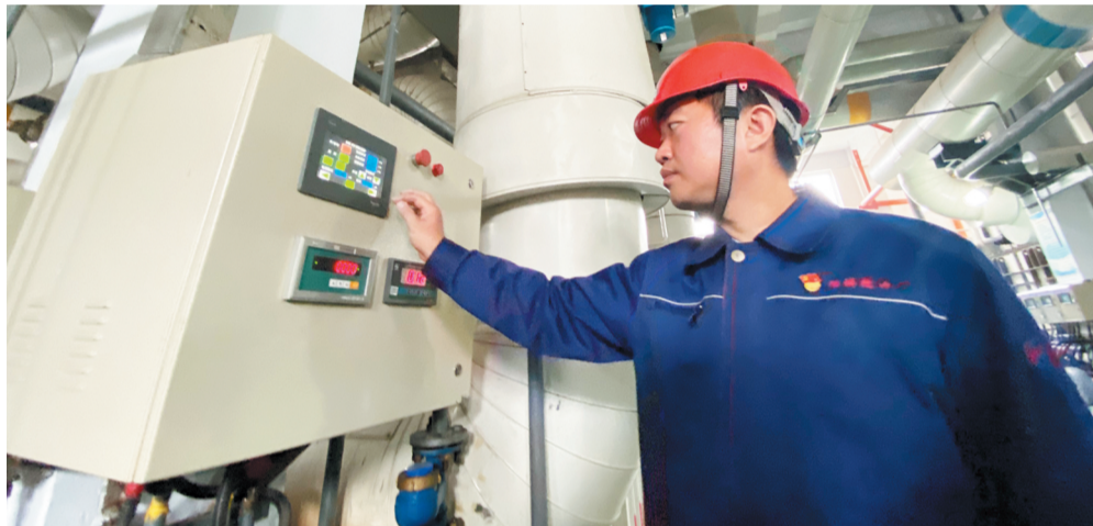
开泰工业余热利用首站，工作人员正在调试相关设备。
