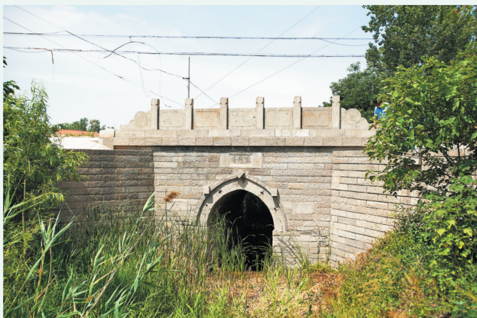
修复后的袞龙桥。
