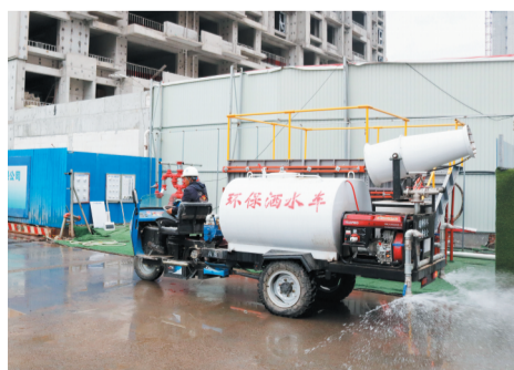
施工现场道路硬化,洒水车每天定时洒水降尘。
