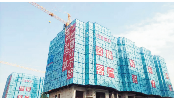
中交通宇(北京)建设工程有限公司承建的淄博万科翡翠东第二期项目主体。
