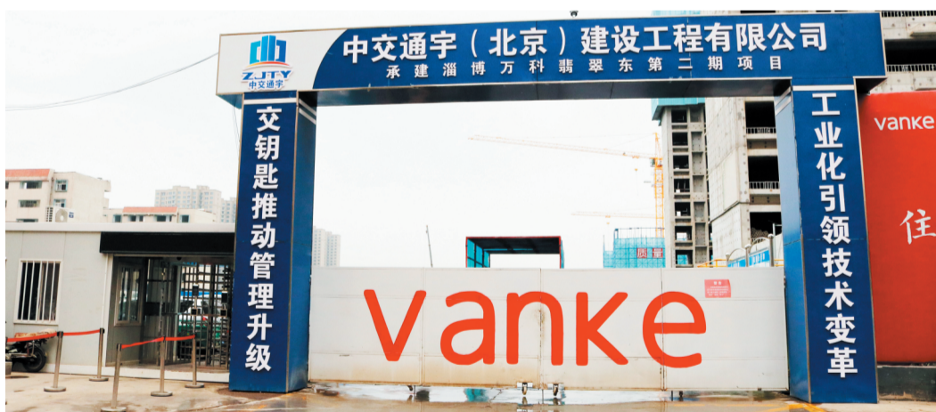
中交通宇(北京)建设工程有限公司承建淄博万科翡翠东第二期项目。
