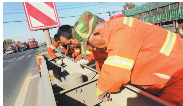
施工人员正在更换护栏。
