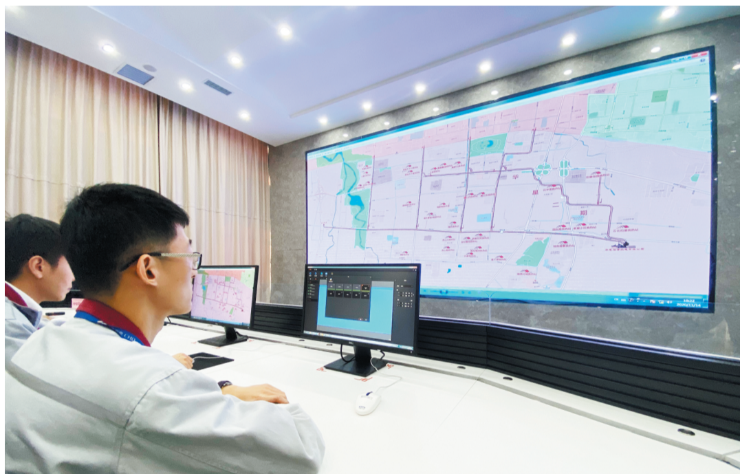
华星热力实现“热源、管网、换热站、楼宇、用户”五级智能调控。
