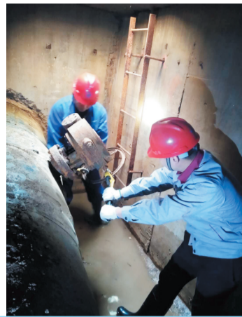
工作人员给热网注水。
